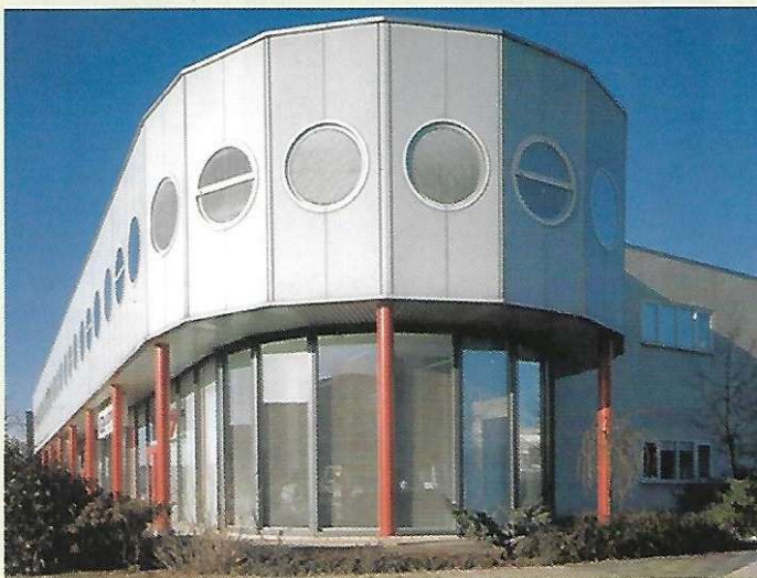
Sinds juni 1989 is Quadrant gehuisvest in een opvallend kantoorgebouw in Capelle aan den IJssel
